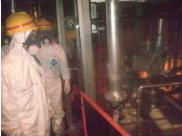
← 5号機トラス室
