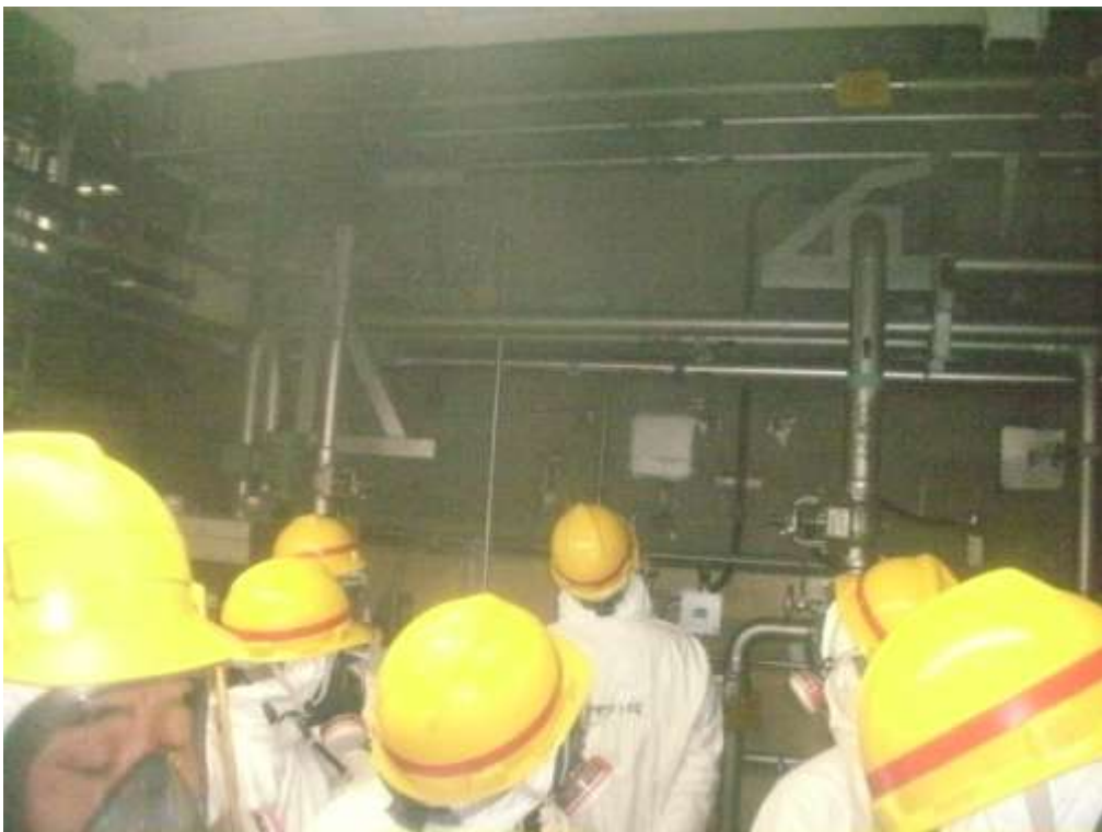
↑ 5号機使用済燃料プール壁 (3階西側壁)
