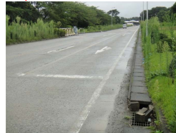
正門からの直線道路には特に異常なし。 「平成23年8月26日 東京電力撮影」
