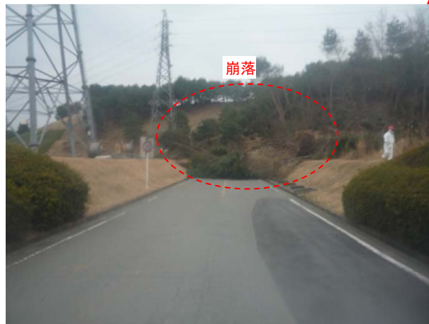
防災道路ではないが斜面崩落し道路が塞がれ通行不可能。 「平成23年3月20日 東京電力撮影」
