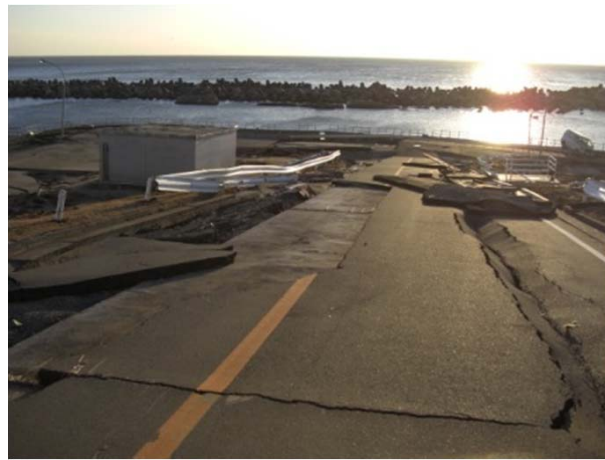
道路補強工事を実施した箇所であるが、補強していない道路両脇に割れ及び段差が発生。 「平成23年3月17日 東京電力撮影」
