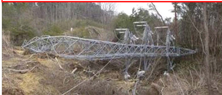
写真⑧. 倒壊した夜の森線1L及び2Lの鉄塔(No.27)
