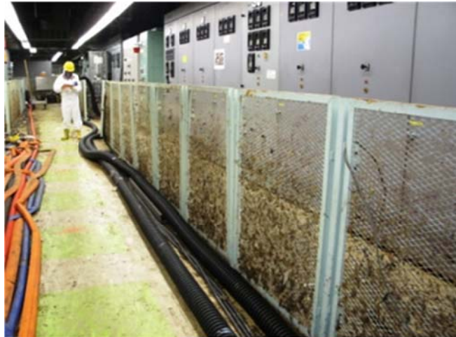
写真①. 1号機タービン建屋1階北側のM/C (肩の高さまで津波の痕跡が残る)
