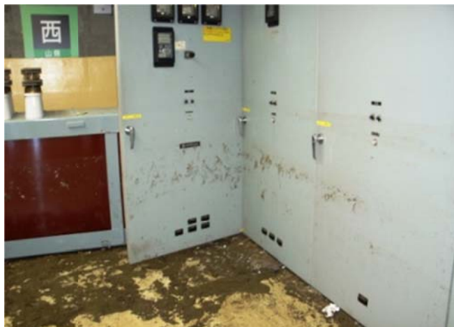
写真②. 1号機タービン建屋1階北側のM/C (奥に見える装置は箱から引き出された遮断機)
