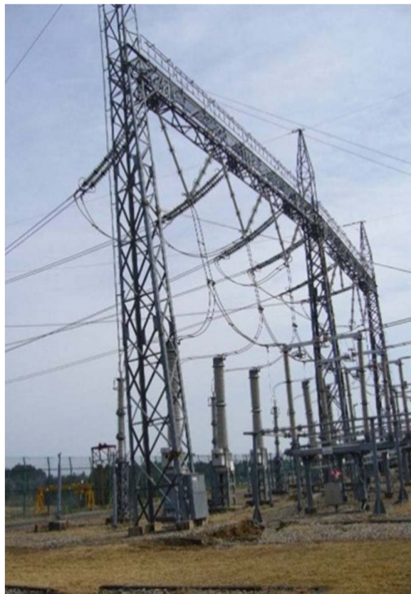
写真⑦. 傾斜した大熊線3L及び4Lの引込鉄構
