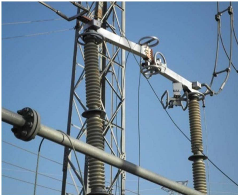
写真⑥. 新福島変電所内の断線している架空地線(大熊線3L)
