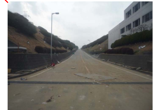
若干瓦礫の散乱があるが道路には特に異常なし。 「平成23年3月20日 東京電力撮影」
