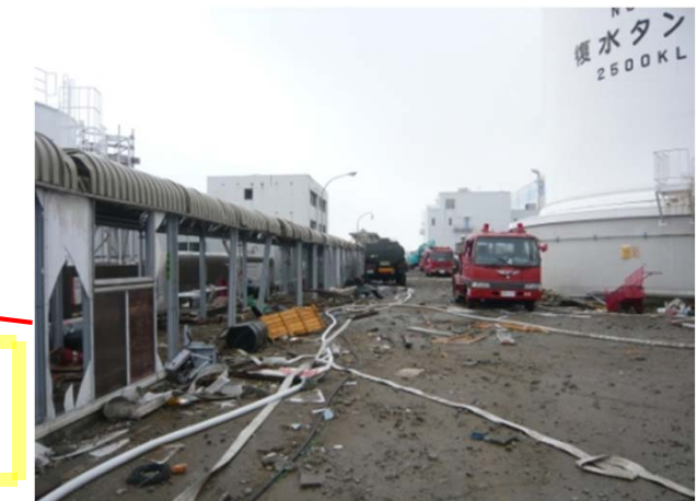
道路には特に異常がないが、津波および爆発による瓦礫が散乱。 「平成23年3月16日 東京電力撮影」
