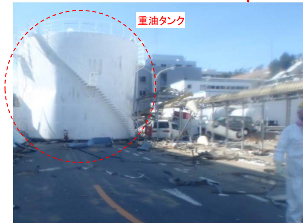
道路は大きな損傷はないが、津波で流された重油タンクが道路を塞ぎ、通り抜け不可能。 「平成23年3月17日 東京電力撮影」
