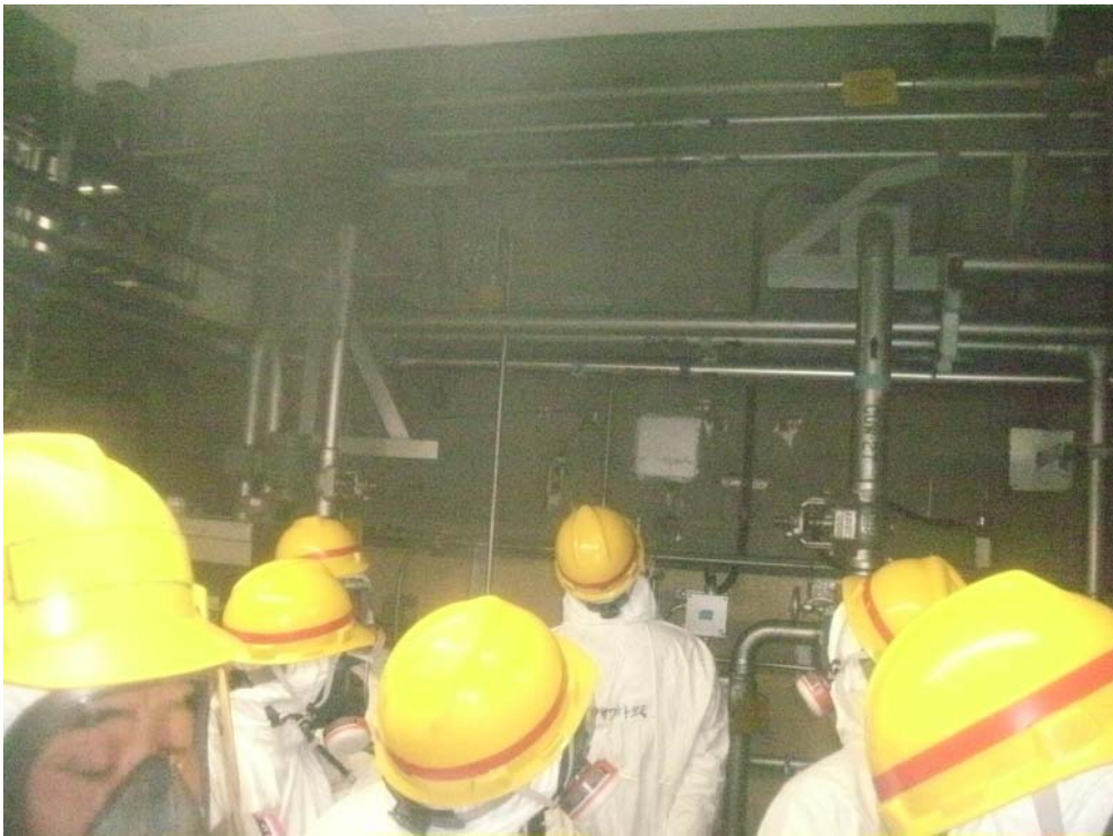
↑ 5号機使用済燃料プール壁 (3階西側壁)
