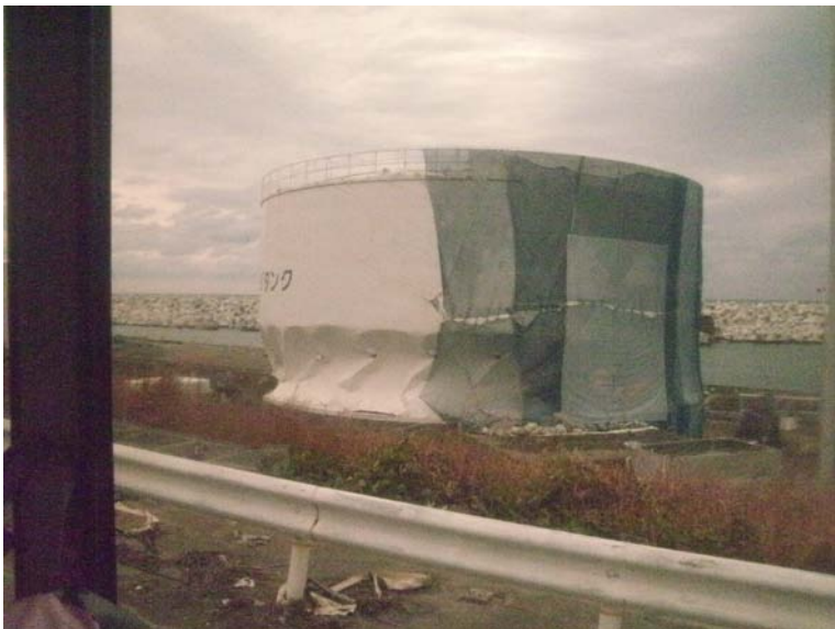
←サブプレッションプールサー ージタンク（5，6号機用）
