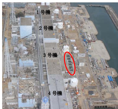
3号機 復水器逆洗弁ピット
