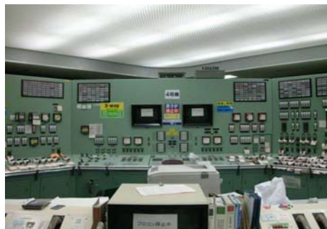
中央制御室の照明復旧(4号機)
