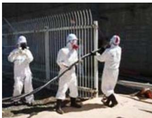
ケーブル敷設作業のイメージ
