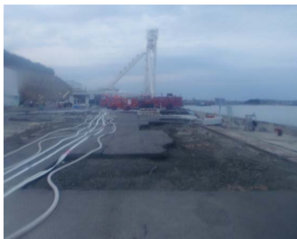
物揚場からの消防車による注水
