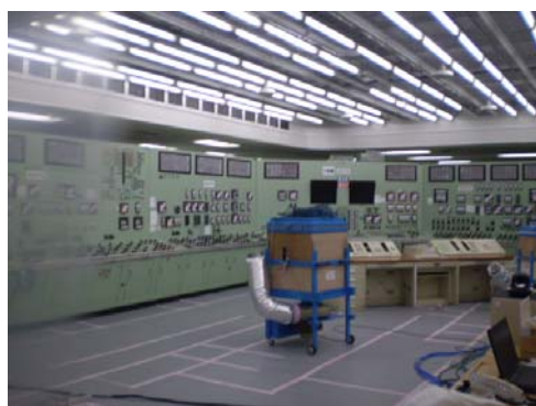
1,2号中央制御室（後日撮影）
