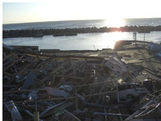
津波襲来後の海側の状況
