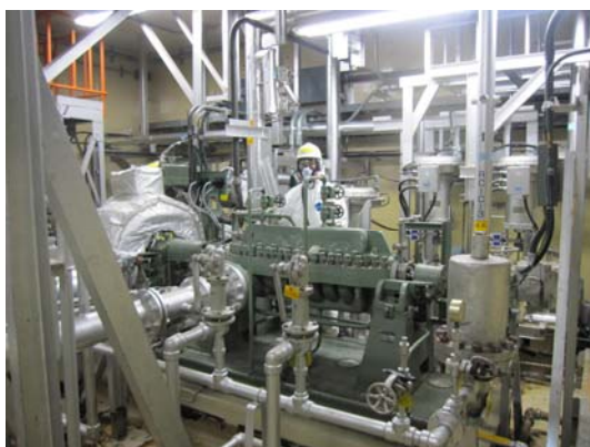
RCIC (5号機 照明あり)
