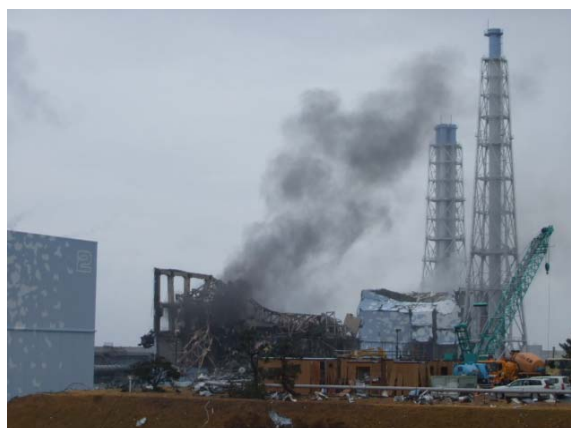
爆発後の3号機の外観 (撮影日: H23. 3. 21)
