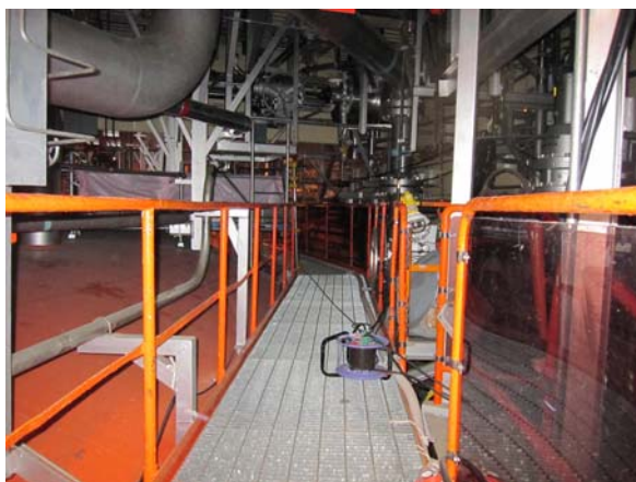
トーラス室の状況（5号機。照明あり）
