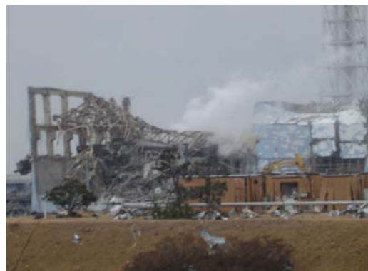
4 号機損傷状況（写真右） （写真左は 3 号機）
