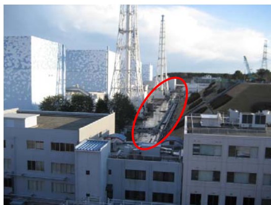
津波により 1~4 号機全域が浸水
