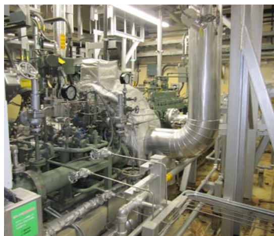
RCIC (5号機 照明あり)
