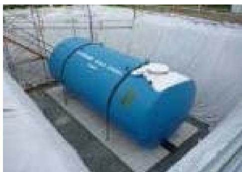
埋設の防火水槽（設置時のもの）
