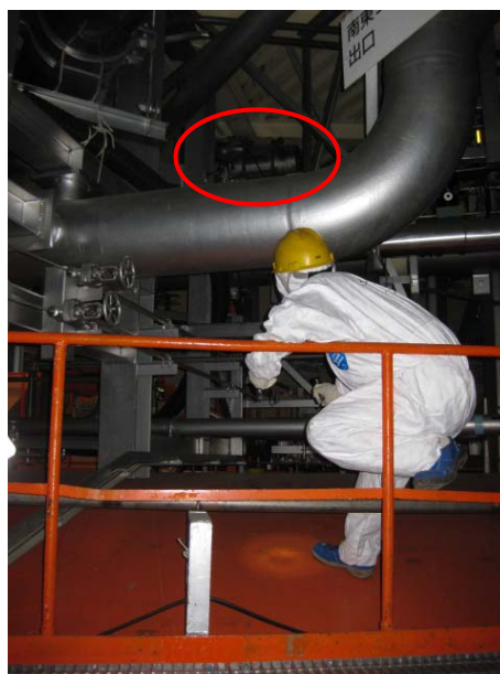
S/Cベント弁確認作業イメージ
