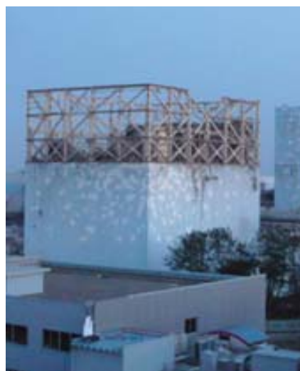
爆発後の1号機原子炉建屋
