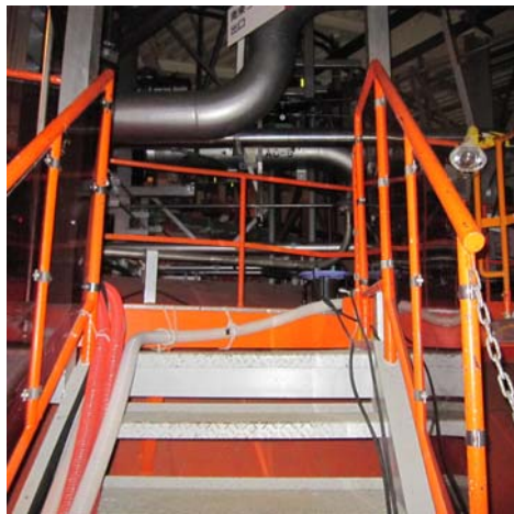
トーラス室入口 (5号機 照明あり)
