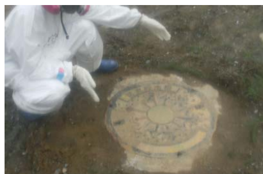
防火水槽の取水蓋
