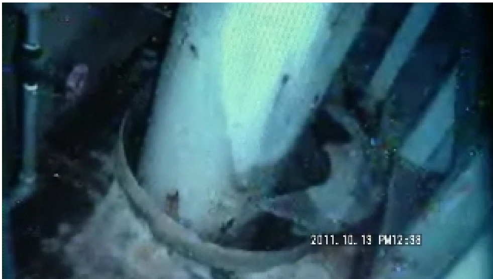
図5.1-3 10月13日撮影の1階床貫通部の状況(蒸気放出無し)
