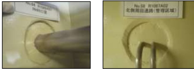
モルタル施工例 (許容水深: 制限なし)
