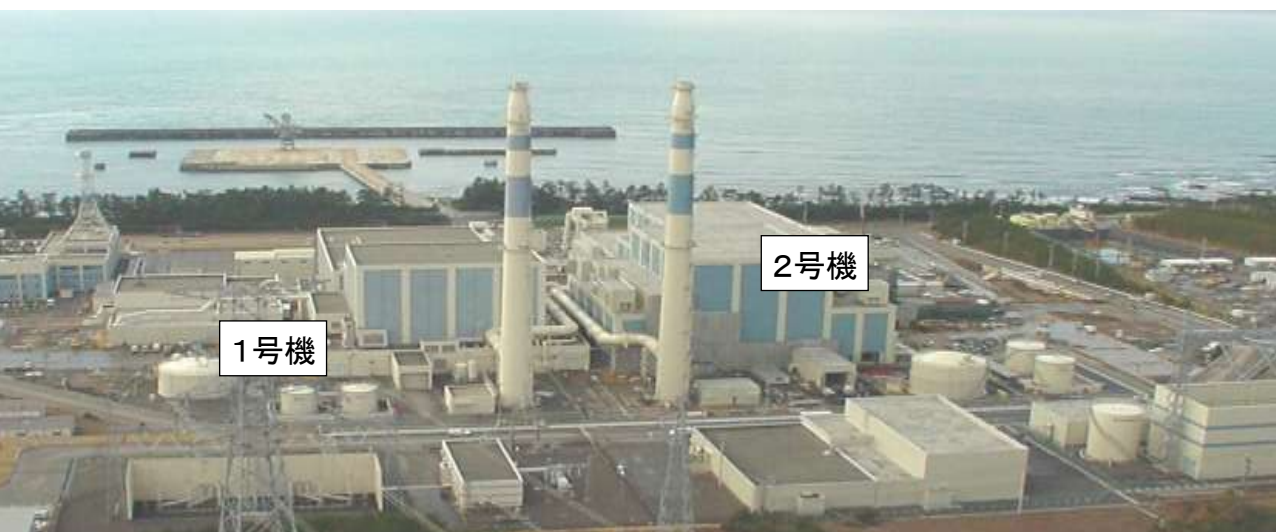
志賀原子力発電所全体写真
