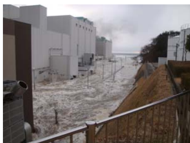
建屋敷地エリアの津波の状況 (1号機南側)
