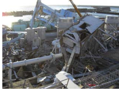
5号機海側海水ポンプエリア
