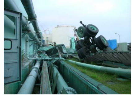
4号機タービン建屋東側
