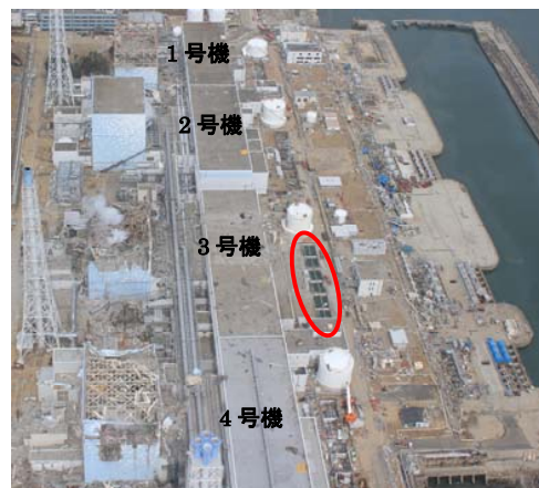
3号機 復水器逆洗弁ピット
