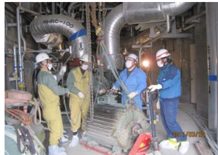
ポンプモータ復旧作業 (作業状況は後日のもの)
