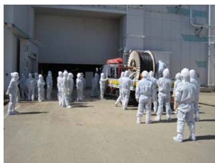
仮設ケーブル敷設準備 (作業状況は後日のもの)
