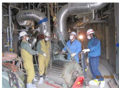
ポンプモータ復旧作業 (作業状況は後日のもの)
