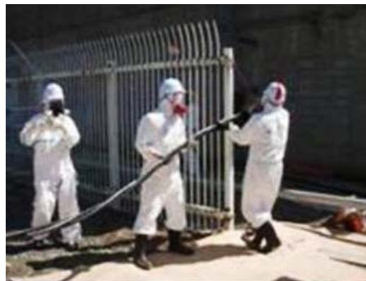
ケーブル敷設作業のイメージ
