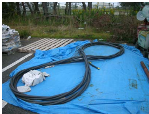
写真のケーブルは約 15m で重さは約 90kg。1,2 号の電源復旧はこの 10 倍以上の長さを使用。(後日撮影)
