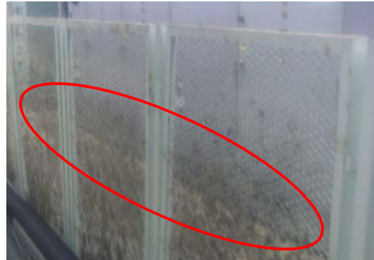
1号機タービン建屋1階M/Cの状況
