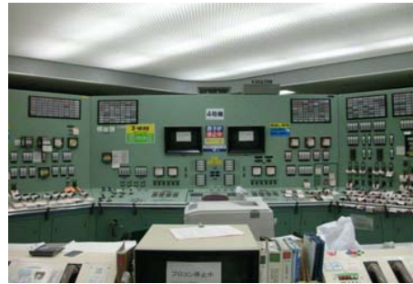
中央制御室の照明復旧(4号機)
