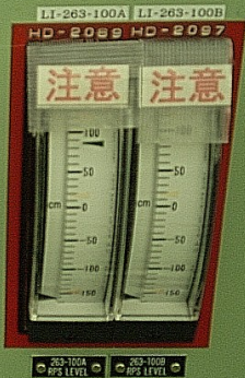
一時的に指示が確認できた原子炉水位 (計器脇に読み値を記載し監視継続)
