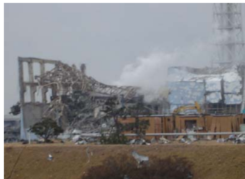
4 号機損傷状況（写真右） （写真左は 3 号機）
