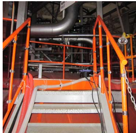
トーラス室入口（5号機 照明あり）
