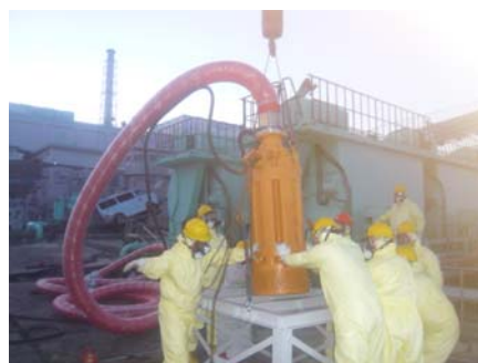
水中ポンプ設置作業の状況
