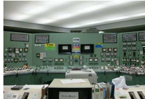
中央制御室の照明復旧(4号機)
