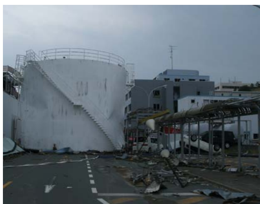
津波で流されて道をふさいだ重油タンク (直径11.7m×高さ9.2m)
