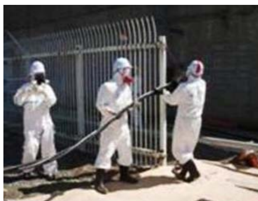
ケーブル敷設作業のイメージ
