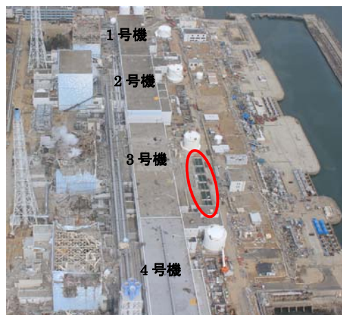
3 号機 復水器逆洗弁ピット
