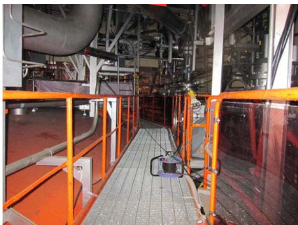
トラス室の状況 (5号機。照明あり)
