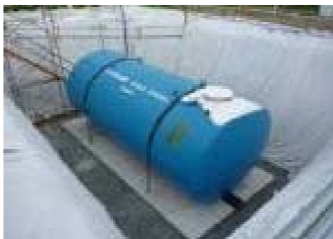
埋設の防火水槽（設置時のもの）
