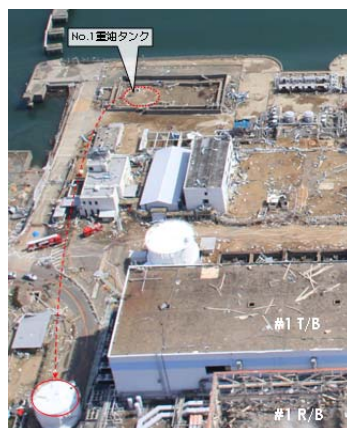
重油タンクは、津波により1号機タービン建屋北側脇まで漂流
