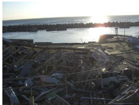
津波襲来後の海側の状況
