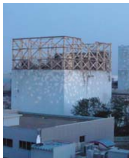
爆発後の1号機原子炉建屋
