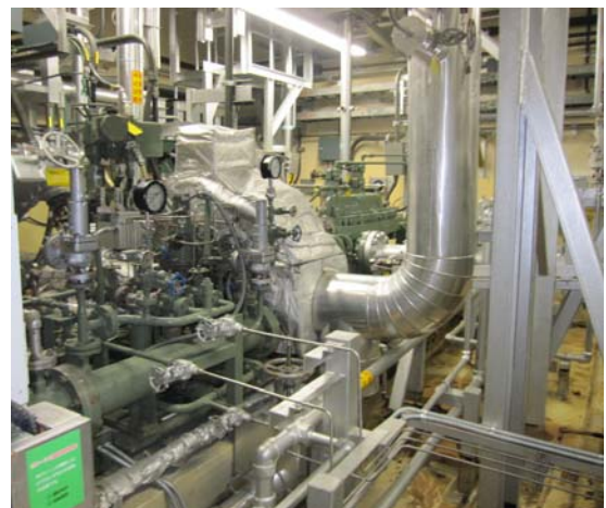
RCIC (5号機 照明あり)
