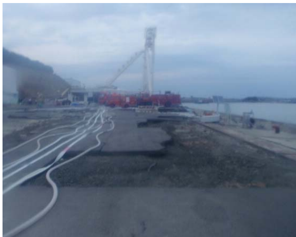
物揚場からの消防車による注水
