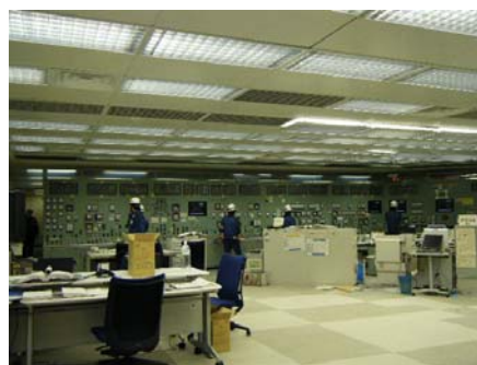
津波到達後の中央制御室
