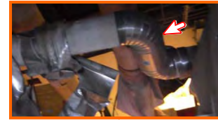
IC入口蒸気配管
