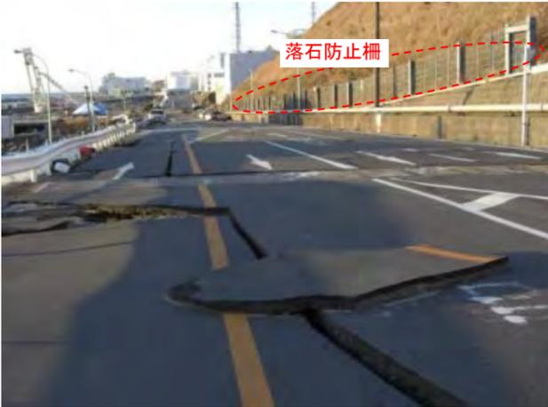
海側片車線が道路と平行に割れ段差が発生。西側の通行は可能。 3/17撮影
