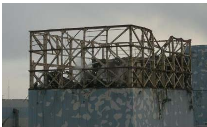
図 1号機原子炉建屋の外観写真
