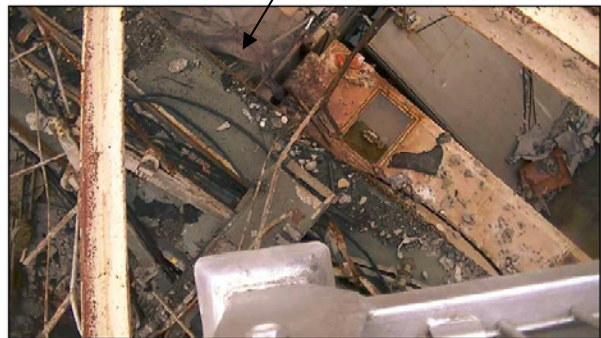
撮影者: 東京電力株式会社 撮影日: 平成23年8月24日
