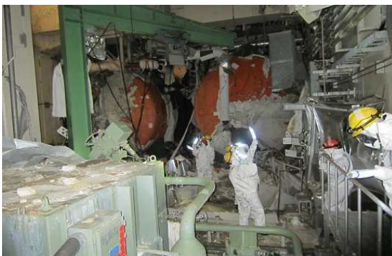
福島第一原発1号機原子炉建屋の現地調査
