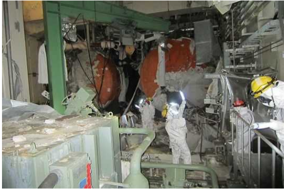
1号機原子炉建屋4階
