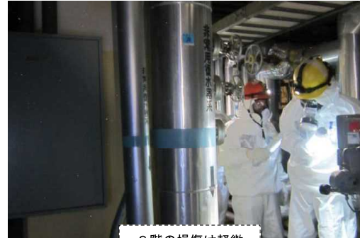
3階の損傷は軽微
