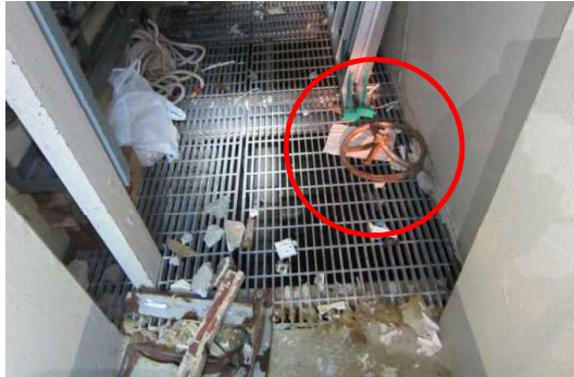
写真 1-8 原子炉建屋 4 階の破損したハンドル (南)
