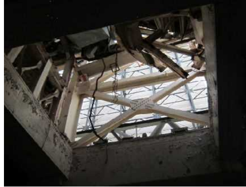
1号機原子炉建屋4階 機器ハッチ
