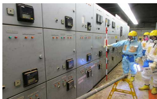
福島第一原発 1号機タービン建屋の現地調査
