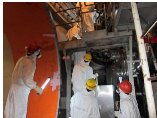
5号機格納容器内
