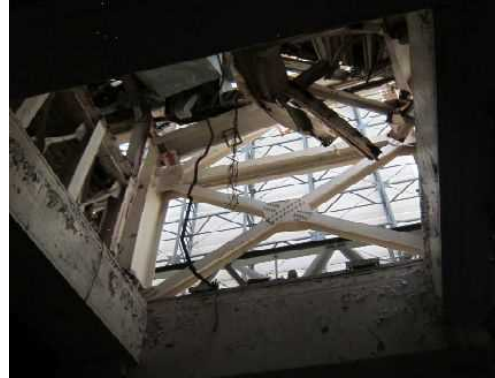
1号機原子炉建屋4階 機器ハッチ
