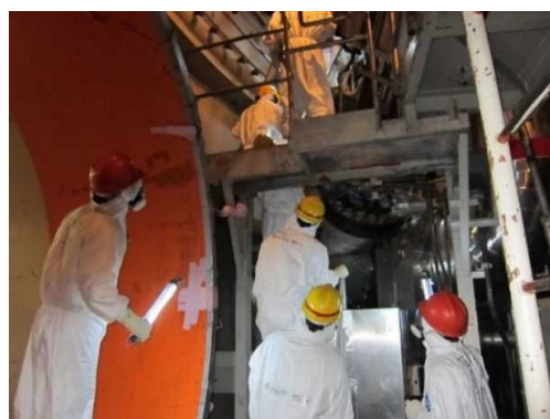
5号機格納容器内
