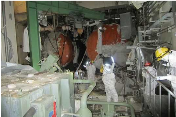
1号機原子炉建屋4階
